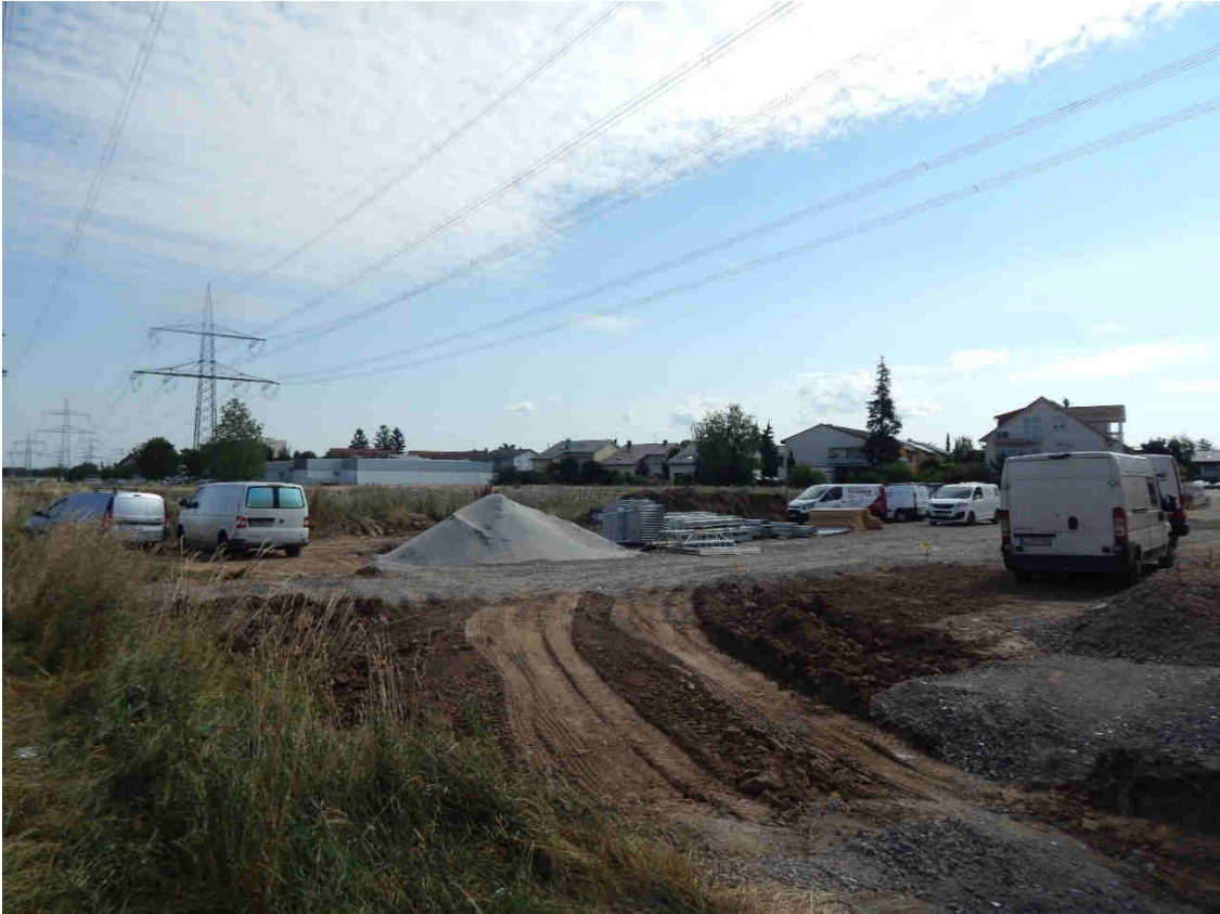
Abb. 6: Blick von der benachbarten Baustelle aus nach Nordosten Richtung Wohnbebauung und Lebensmittelmarkt Lidl.
